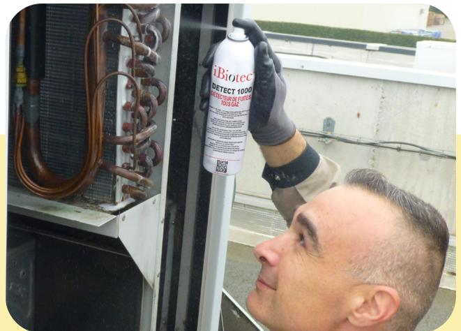
"J'utilise le produit détecteur de fuites gazeuses en aérosol pour localiser précisément les fuites de fluide frigorigène. Les détecteurs électroniques ne permettent qu'une localisation grossière. L'avantage d'IBIOTEC DÉTECT 1000 est que la pression reste disponible, même si l'aérosol est resté dans une température ambiante basse. Le détecteur de fuites que j'utilisais avant avait du mal à sortir de l'aérosol lorsqu'il faisait froid, et il y avait très peu de bulles."
